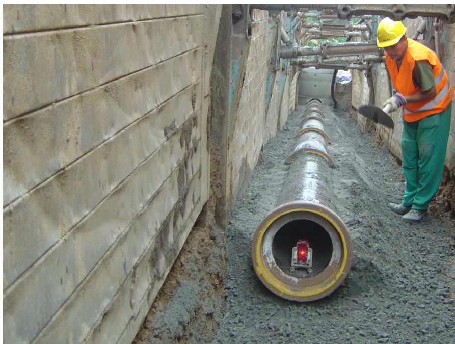
Obr. Ukládání kanalizačního řadu v Radlické čtvrti
