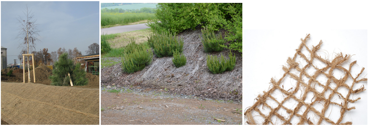
Modelová ukázka stabilizací svahu protierozní sítí. Obrázek vpravo: Kokosová protierozní síť JUTENON ECC 400 g/m 2 , převzato: http://e-shop.juta.cz/index.php?page=1&vyr=JN005
