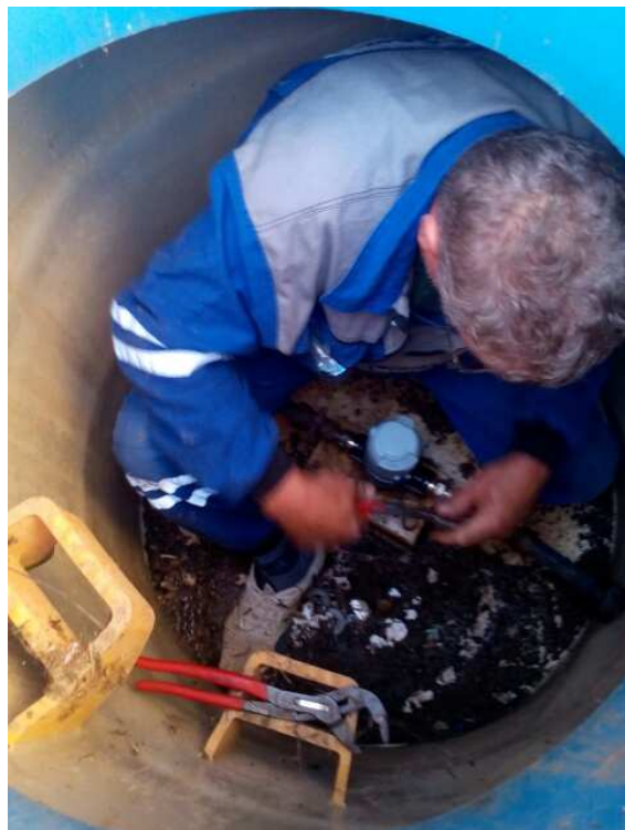
Obr. 4: Výměna vodoměru
