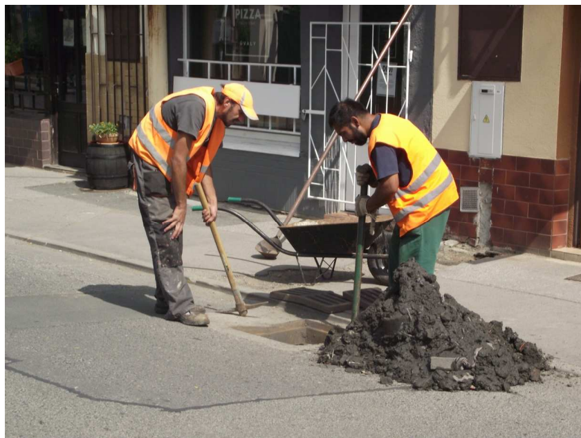
Obr. 17: Čištění dešťových vpustí
