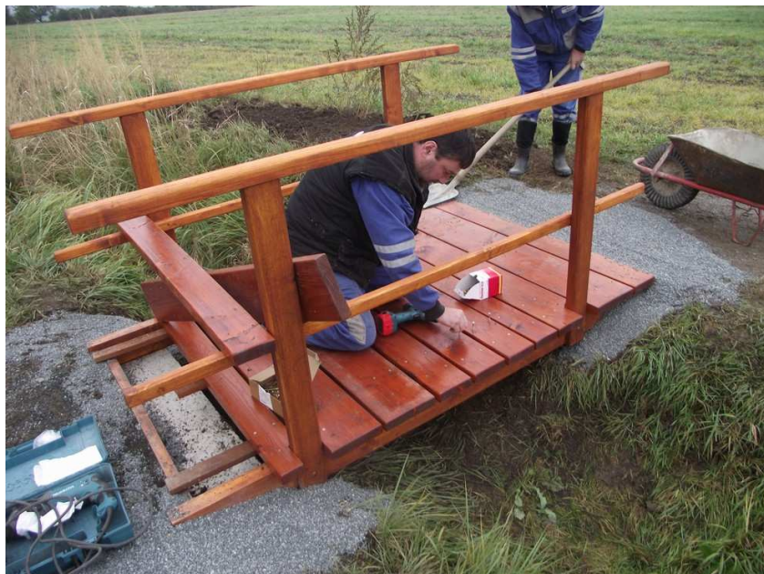
Obr. 17: Instalace mostku v Horoušánkách
