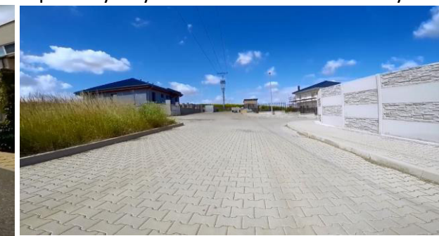
Obrázek 4 – povrch ze zámkové dlažby bez závad
