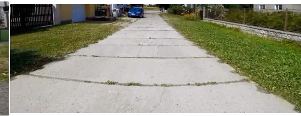
Obrázek 12 - panely se středními poruchami
