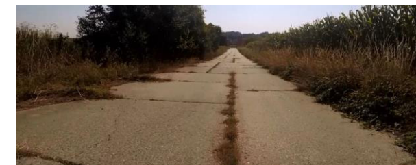
Obrázek 15 - panely s těžkými poruchami
