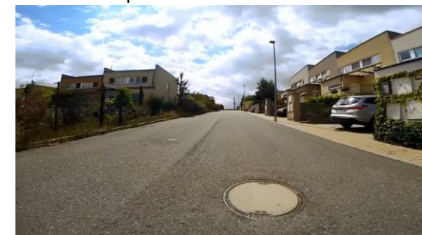
Obrázek 3 - asfaltový povrch bez závad
