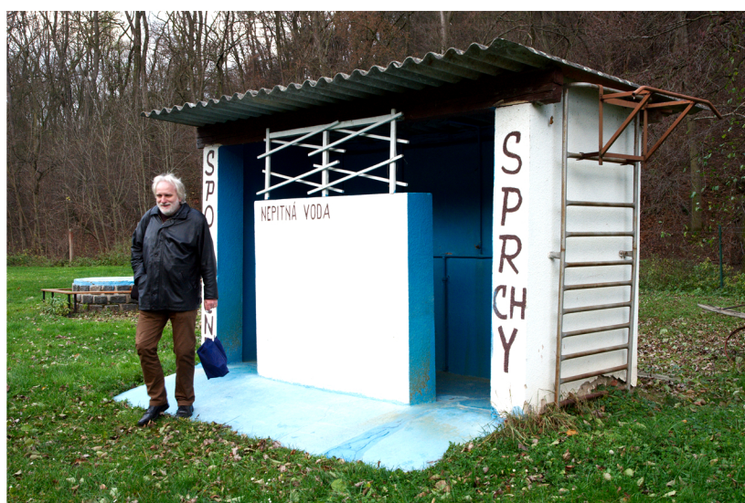
Venkovní pohled na objekt sprch
