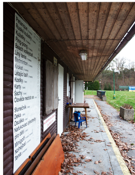
Boční pohled na provozní objekt
