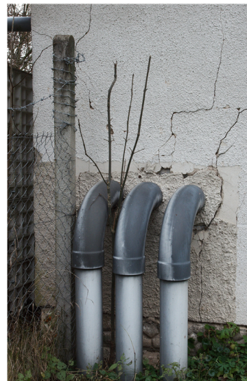
Popraskané stěny úpravny vody
