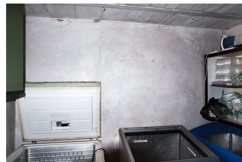
Zadní stěna vstupního objektu
