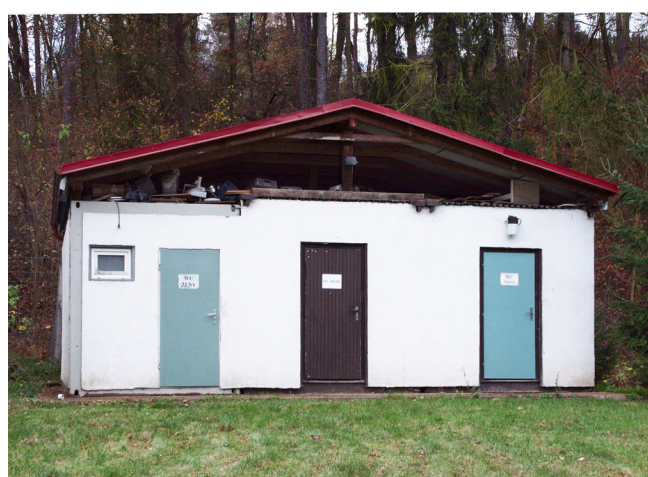
Objekt sociálního zařízení
