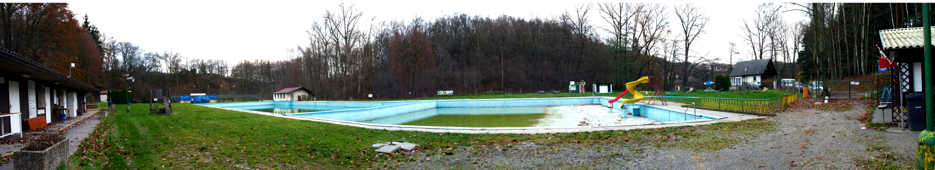
Pohled na koupaliště z prosotru mezi provozním a vstupním objektem
