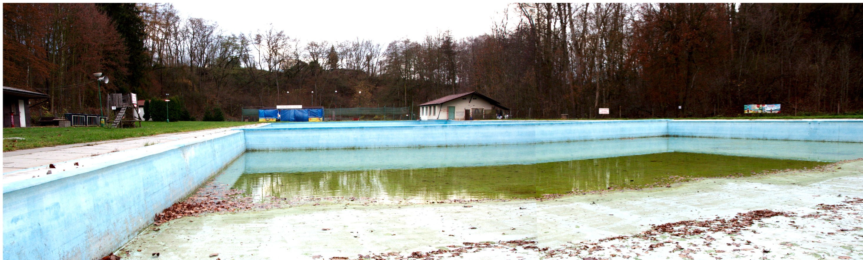
Pohled na menší bazén od vstupního schodiště
