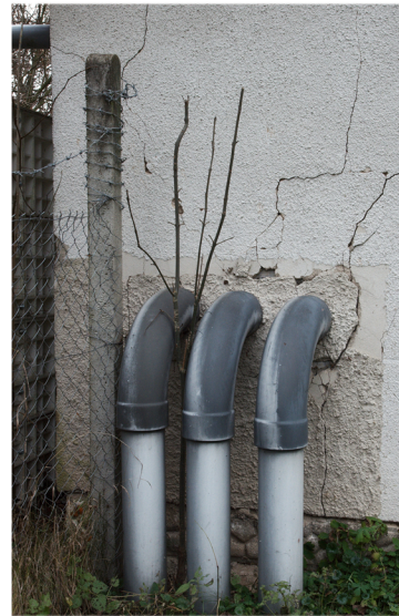
Popraskané stěny úpravny vody
