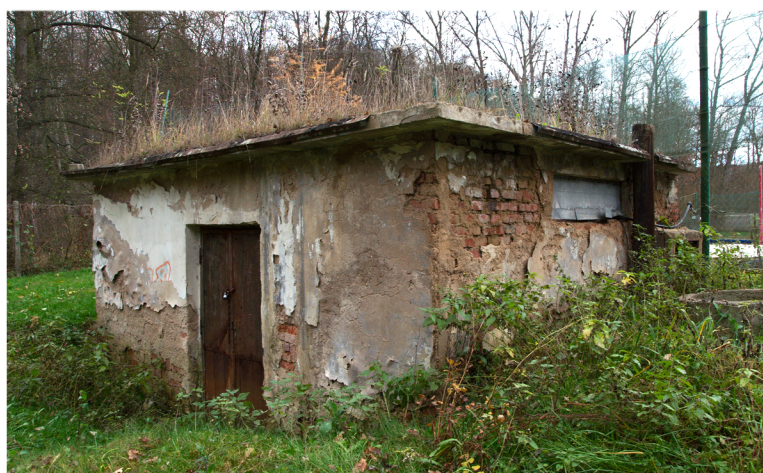
Pohled na objekt studny
