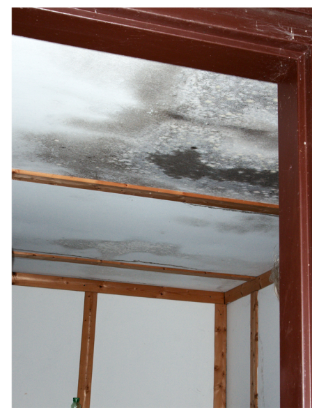
Vnitřek provozního objektu
