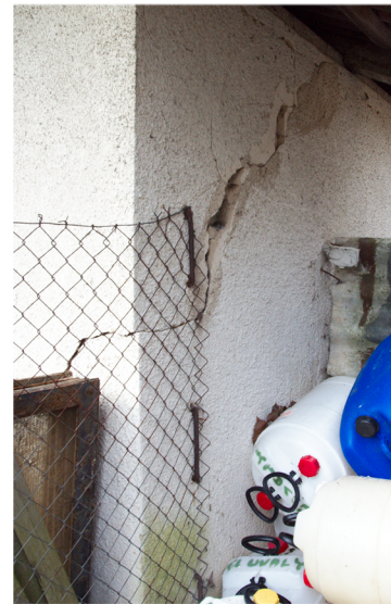
Popraskané stěny úpravny vody
