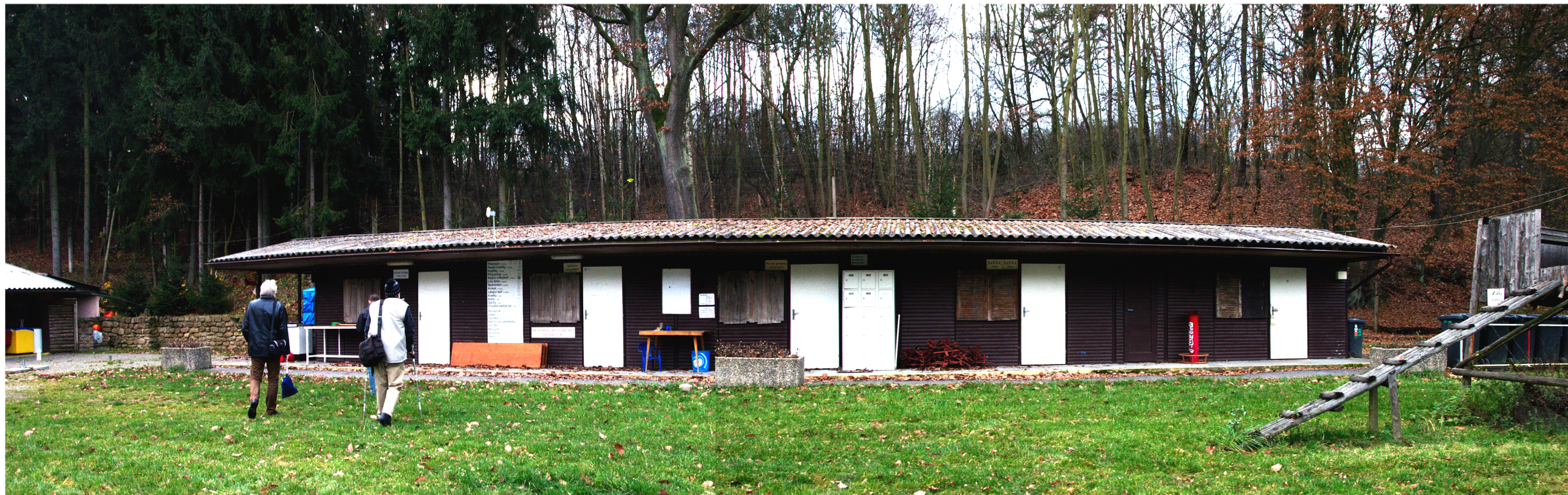
Pohled na provozní budovu od bazénu
