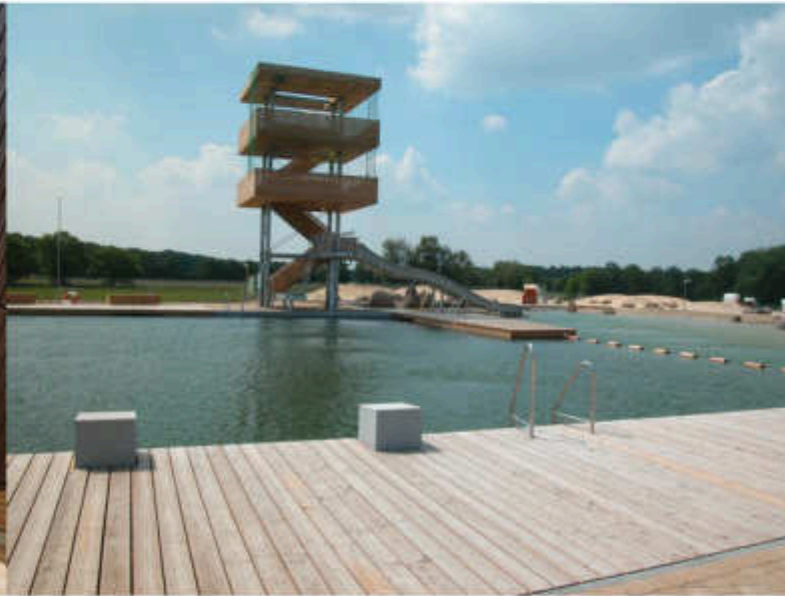
betonové skokánky, nerez zábradlí
