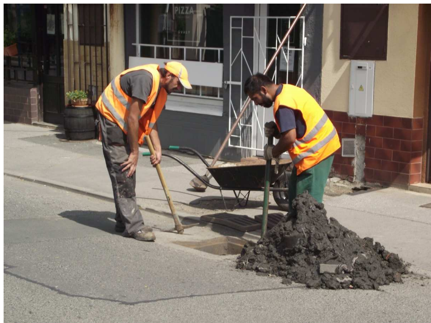
Obr. 17: Čištění dešťových vpustí
