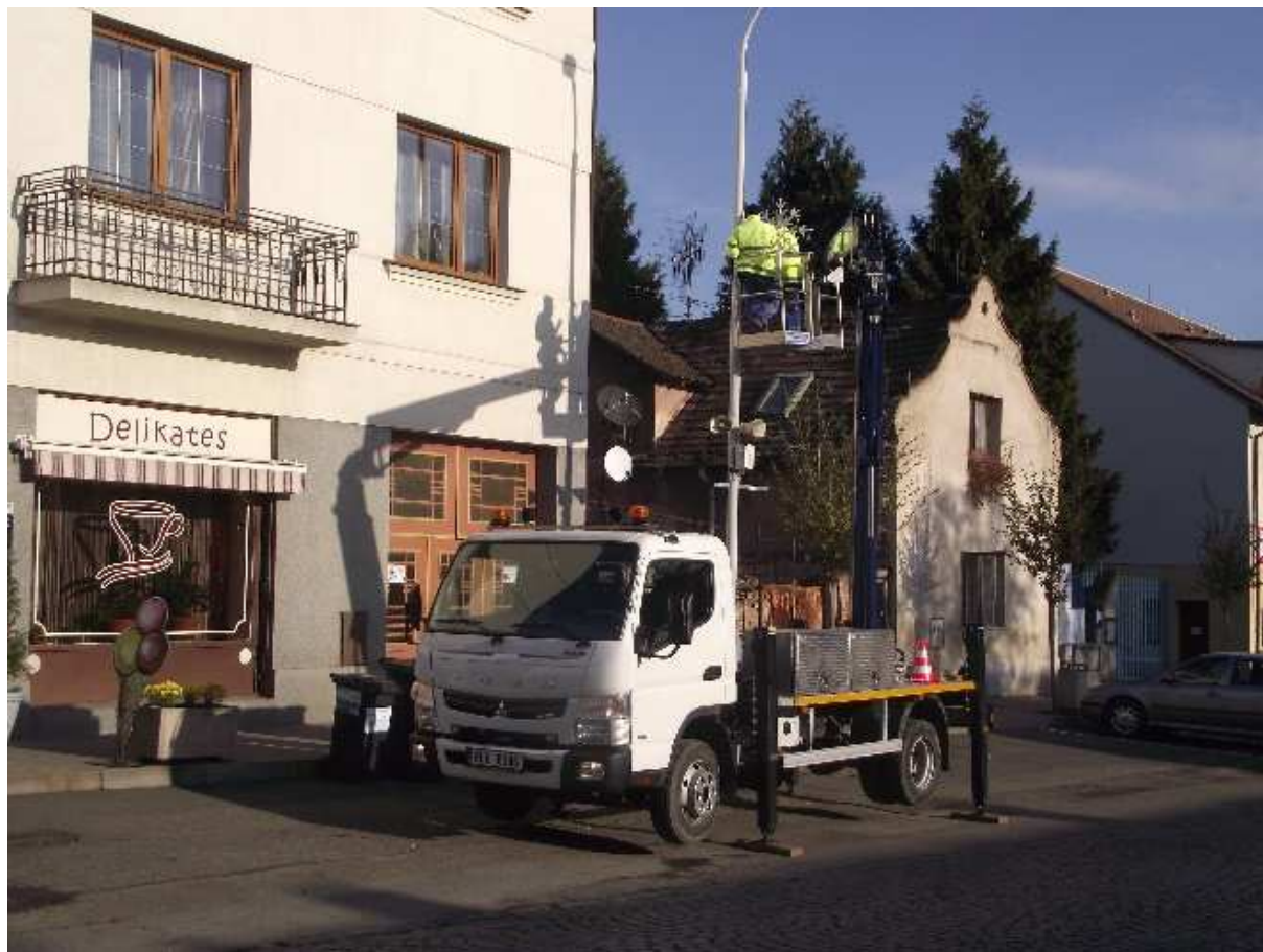
Obr. 5: Instalace vánočního osvětlení na Nám. Arnošta z Pardubic
