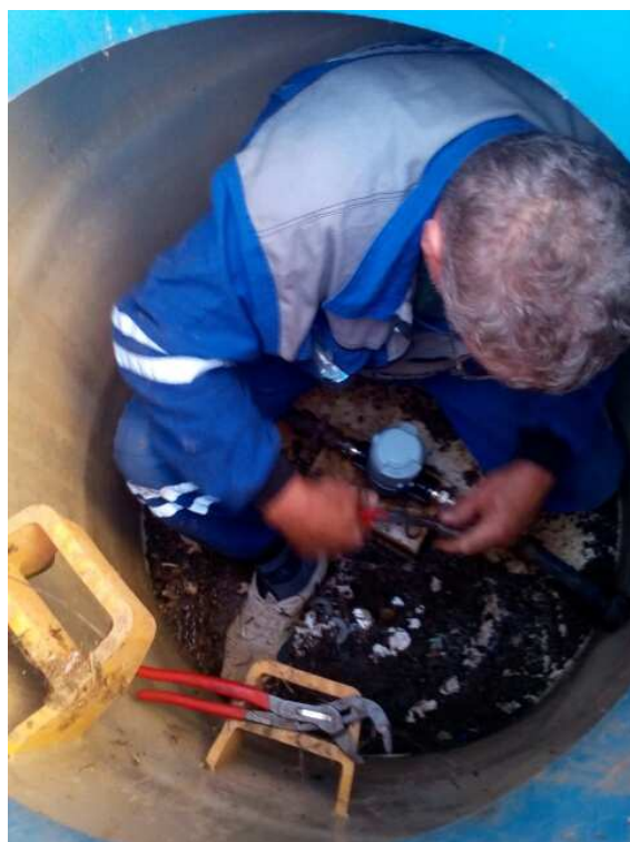
Obr. 4: Výměna vodoměru
