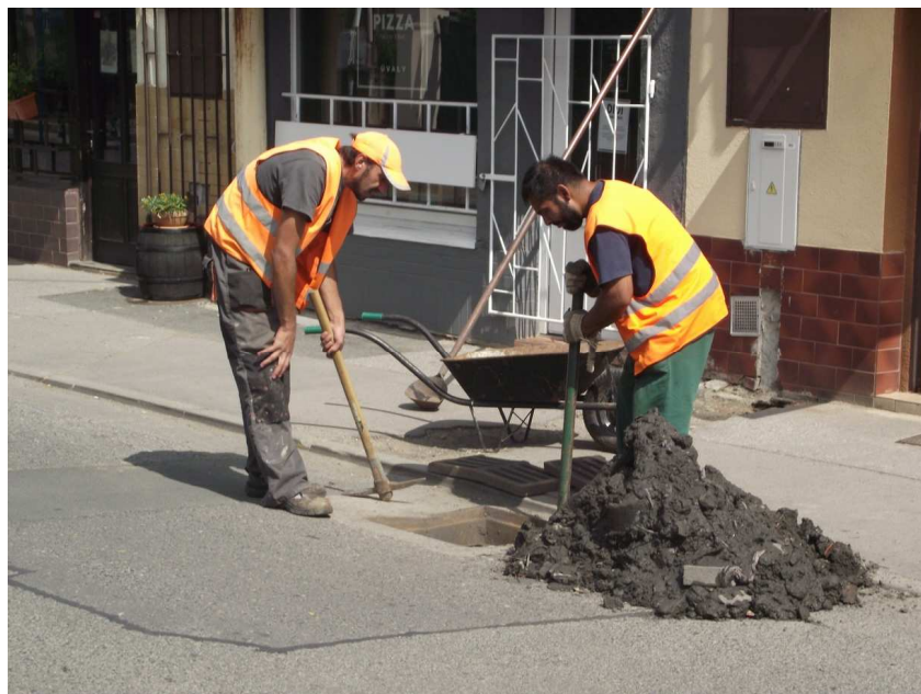
Obr. 17: Čištění dešťových vpustí
