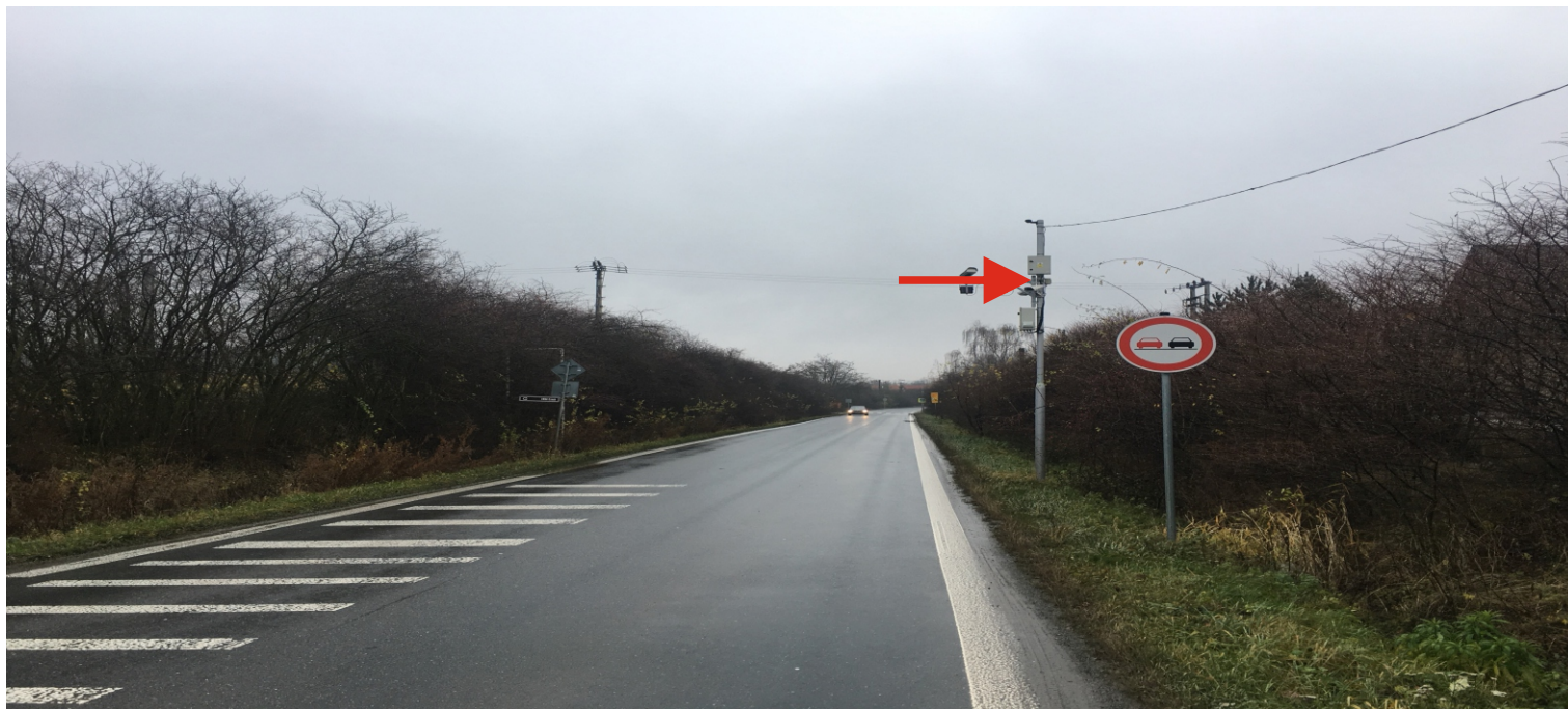
POHLED NA SLOUP S UMÍSTĚNÍM TECHNOLOGIE, SMĚR VJEZD DO ÚVAL
