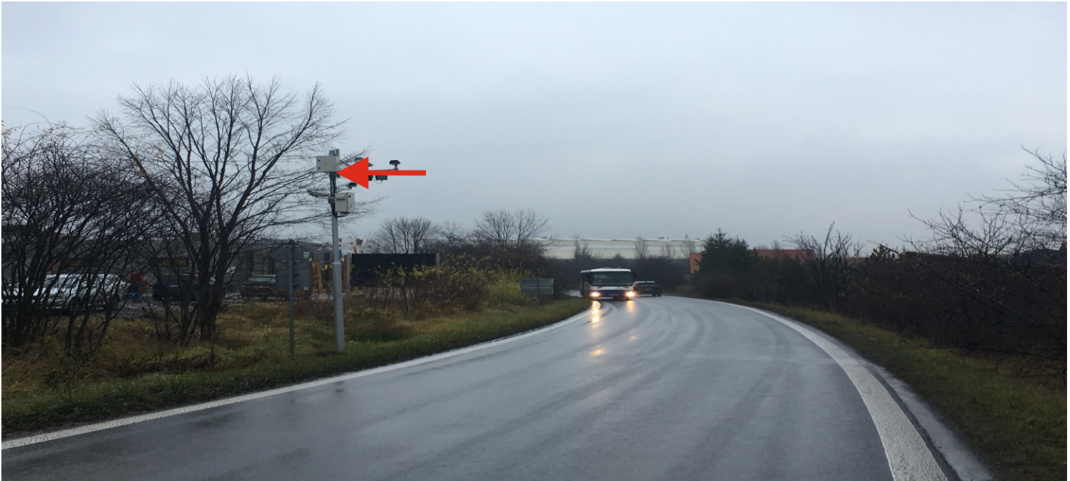
POHLED NA SLOUP S UMÍSTĚNÍM TECHNOLOGIE, SMĚR VÝJEZD Z ÚVAL
