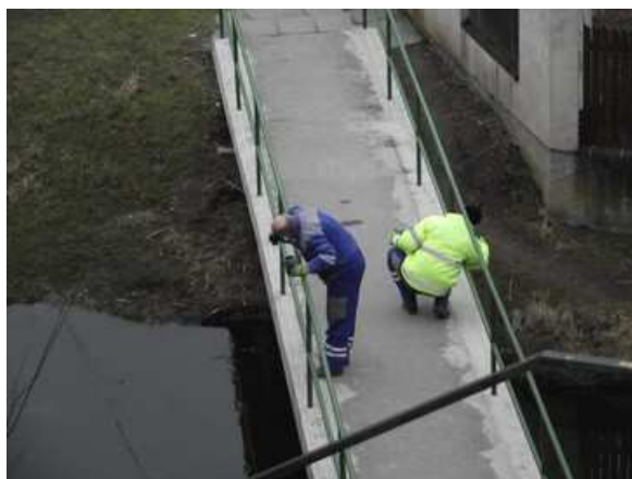
Obr. 21: Oprava zábradlí na lávce
