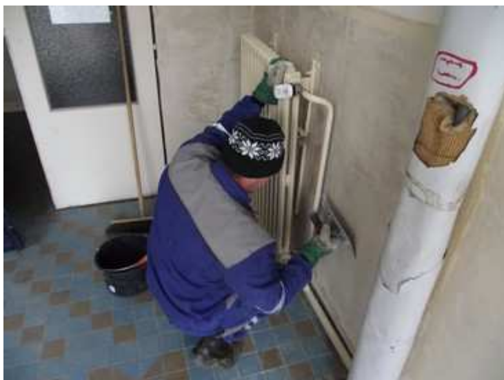
Obr. 6: Opravy společných prostor v nájemních bytech
