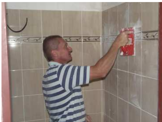
Obr. 7: Oprava sociálních zařízení v MDDM
