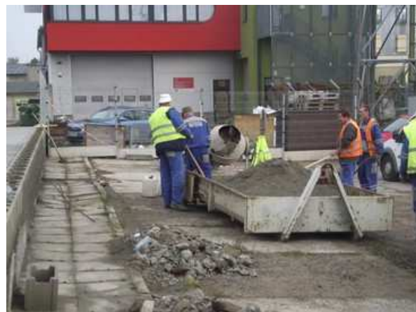
Obr. 24: Rekonstrukce plotu na nádraží
