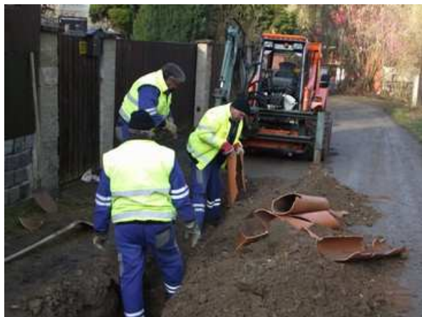
Obr. 20: Odstraňování dešťové kanalizace
