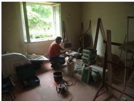
Obr. 8: Rekonstrukce bytu v č. p. 181
