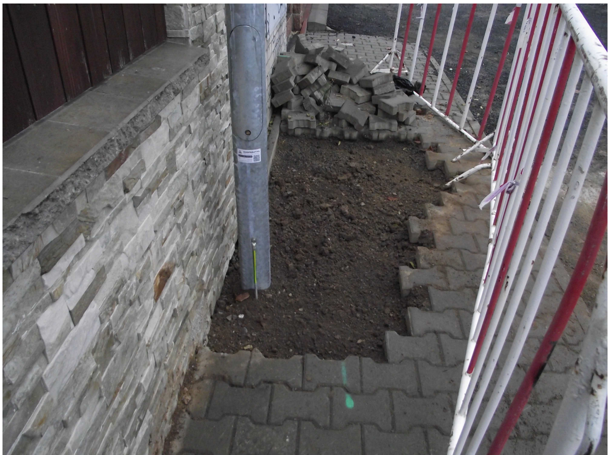
Obr. 1: Realizace nového VO
