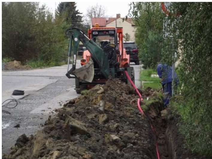
Obr. 17: Výkopy na nové VO
