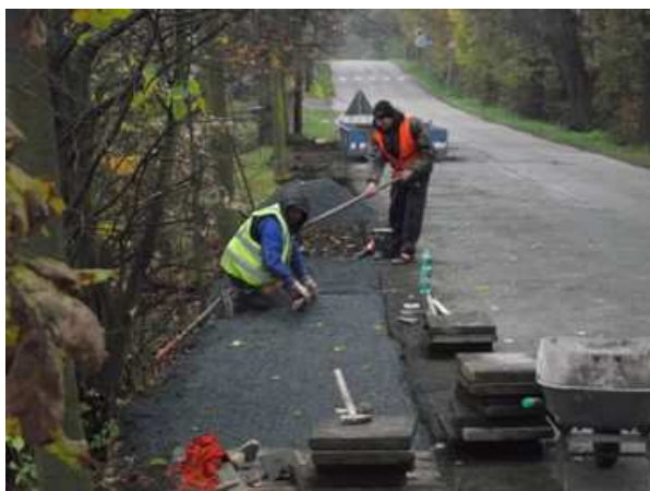
Obr. 14: Rekonstrukce chodníku Pražská
