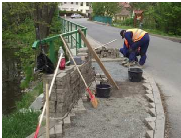
Obr. 15: Oprava chodníku Dobročovická
