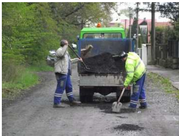
Obr. 12: Oprava výtluků
