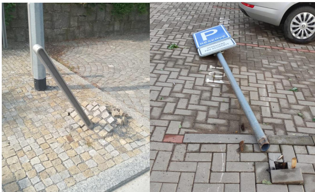
Obr. 23-24: Poničené dopravní značení: sloupek a dopravní značka
