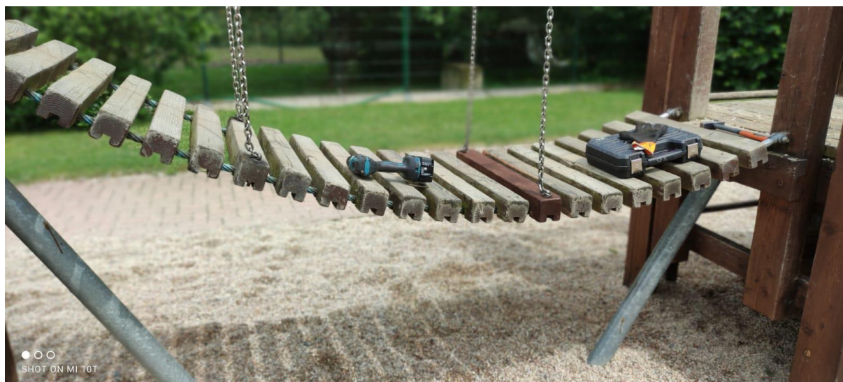
Obr. 18: Oprava mostku na dětském hřišti
