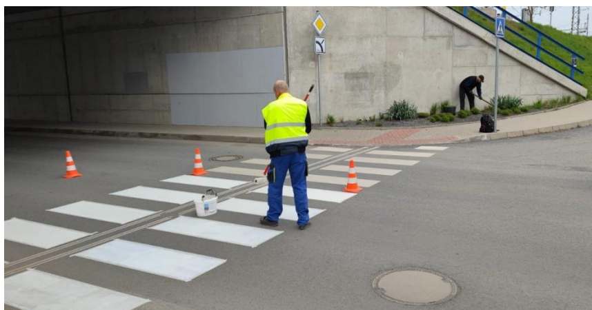
Obr. 25: Vodorovné dopravní značení
