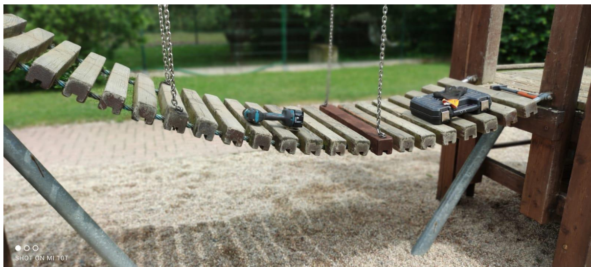
Obr. 18: Oprava mostku na dětském hřišti
