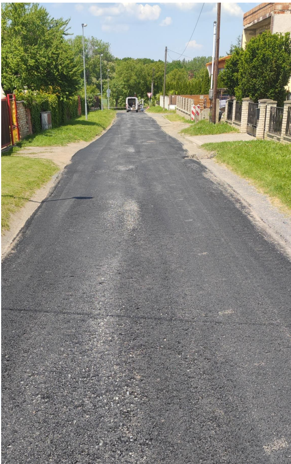
Obr. 26: Oprava povrchu Vodorovné dopravní značení
