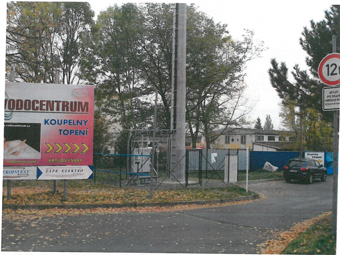
Stávající Základnová stanice Karlovy Vary – Bohatice společnosti CETIN a.s., stožár výšky 35 m, sloupový, železobetonový.
