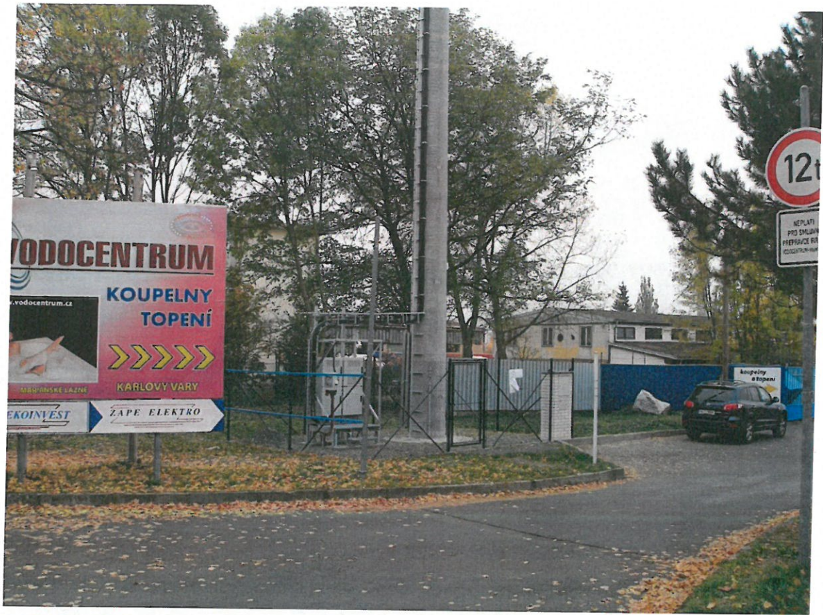
Stávající Základnová stanice Karlovy Vary – Bohatice společnosti CETIN a.s., stožár výšky 35 m, sloupový, železobetonový.
