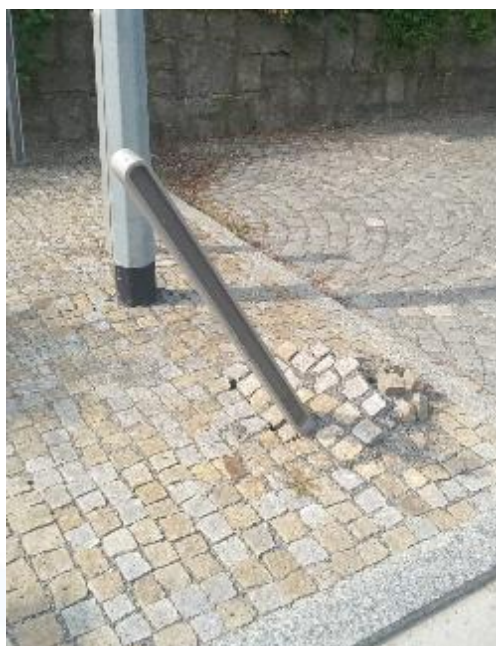
Obr. 23-24: Poničené dopravní značení: sloupek a dopravní značka
