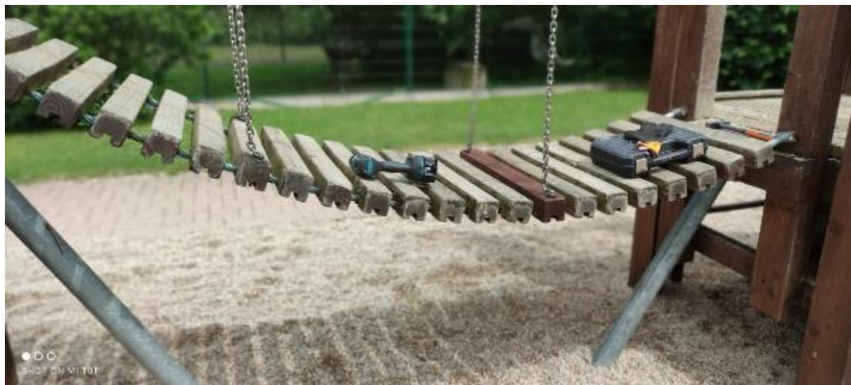
Obr. 18: Oprava mostku na dětském hřišti
