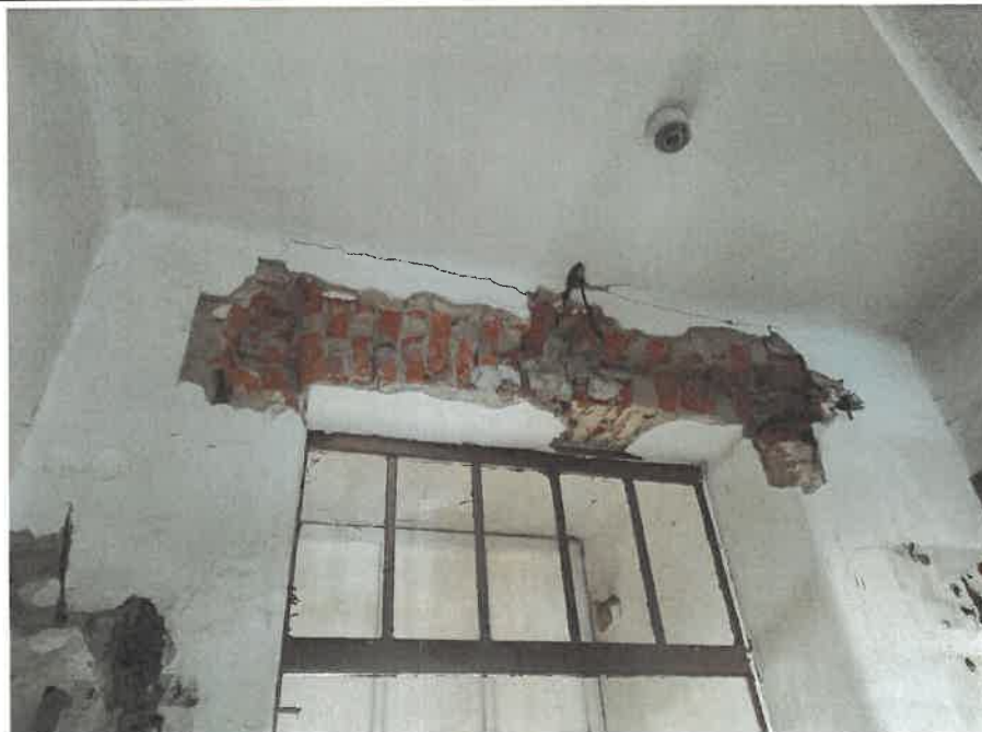
5-Částečná demolice nadokenního překladu
