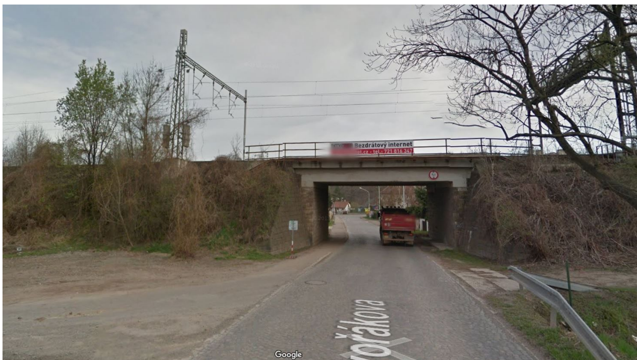
Přibližný záběr pevné kamery 16-2 na ulici Dvořákova a železniční podjezd
