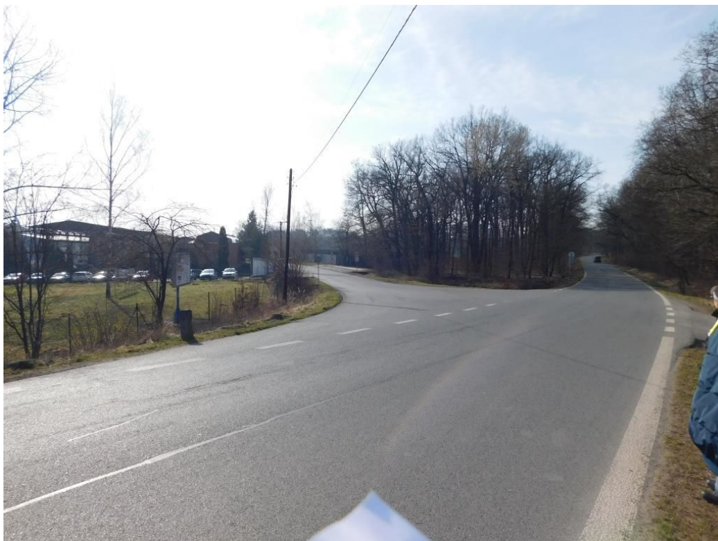
Přibližný záběr pevné kamery 12-2 na silnici č.101 a ulici Klánovická
