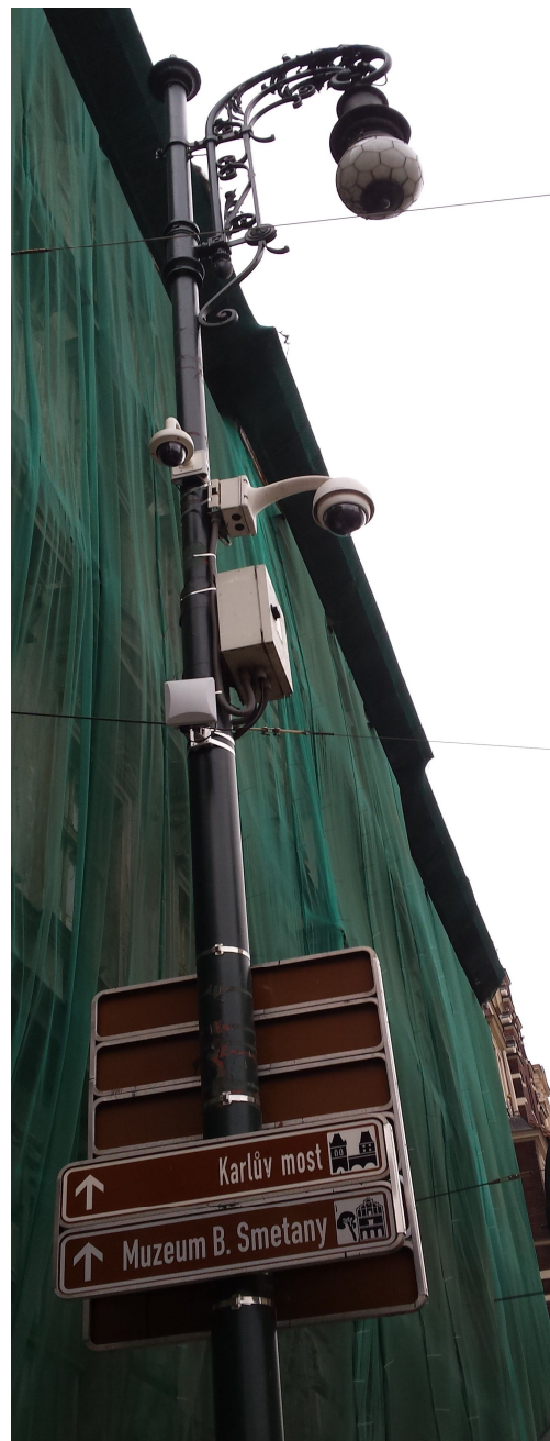
Příklady kamerových stanišť –vlevo na hraněném parkovém sloupu J8 s otočnou kamerou a mikrovlnným spojem , vpravo na historickém sloupu s otočnou kamerou typu autodome a pevnou kamerou typu minidome a se spojem WiFi
